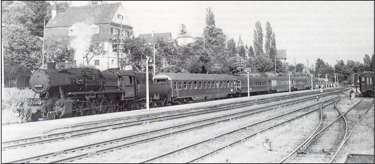
Auch für hochwertige Züge waren die 50er nicht zu schade, wie hier vor einem Touropa-Zug in Überlingen. Als Spezialität hat die 3018 Führerhaus und Tender einer BR 52 erhalten, der Kessel ist noch der ursprüngliche ohne Vorwärmer.
