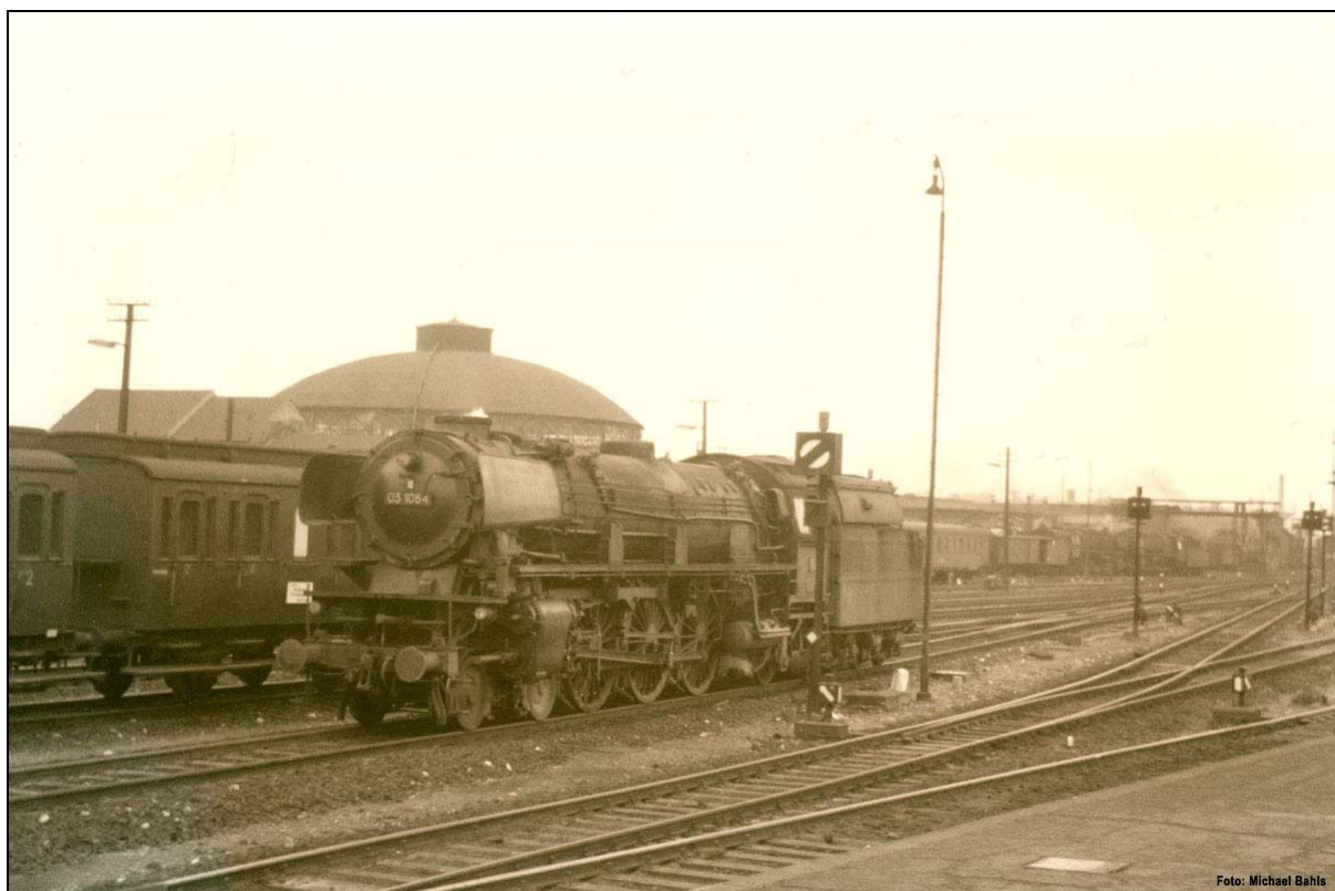
Eine Baureihe 03.10 im Original: Bei genauerem Hinsehen fällt die Tenderabdeckung auf, mit der die DB den Kohlenstaubflug auf die nachfolgenden Schnellzugwagen minimieren wollte. Ein Detail, das Michael Bahls dann auch ins Modell übersetzt hat. Foto: Michael Bahls
